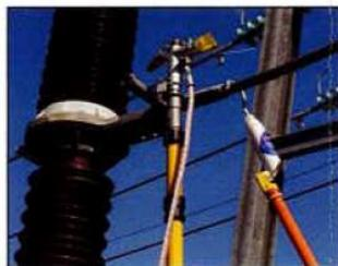
6. Fixer la pince sur une perche isolante pour la placer sur le conducteur.
